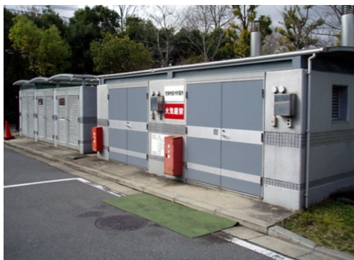
廃液保管庫 (物質創成科学棟南側)
