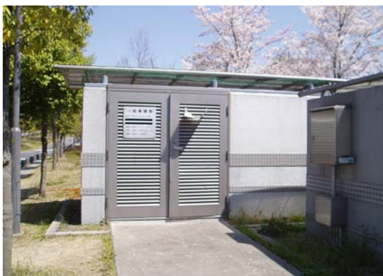
一般廃棄物置場 (バイオ棟)
