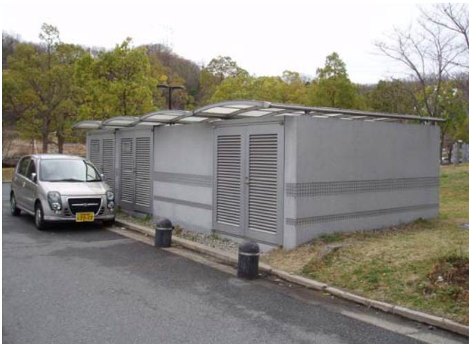
バイオ棟西側に設置された実験排水監視モニター
